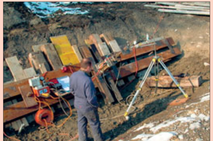
Foundation Aarebrücke; Zugversuch an Mikropfählen.
