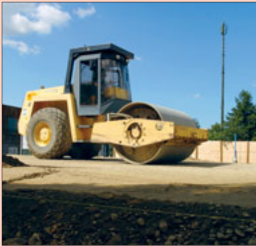
Verdichtung des Dammes; Messeinrichtungen zur Überwachung des Setzungsverhaltens.
