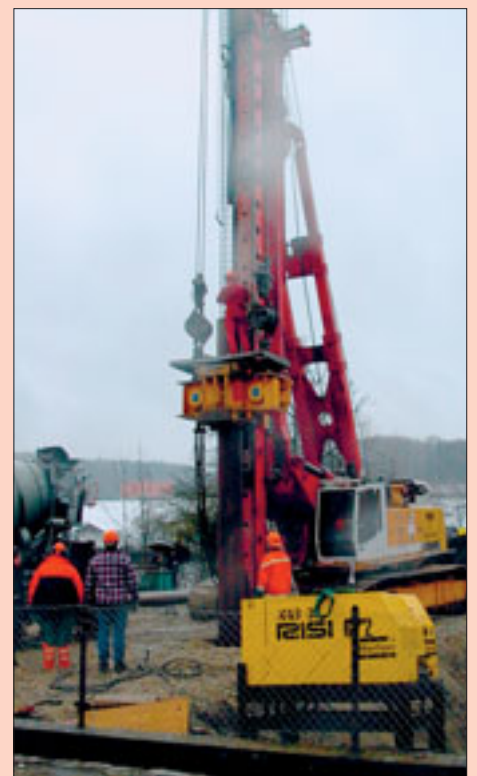
Foundation Aarebrücke; Pfahlmaschine bei der Erstellung von Versuchspfählen.
