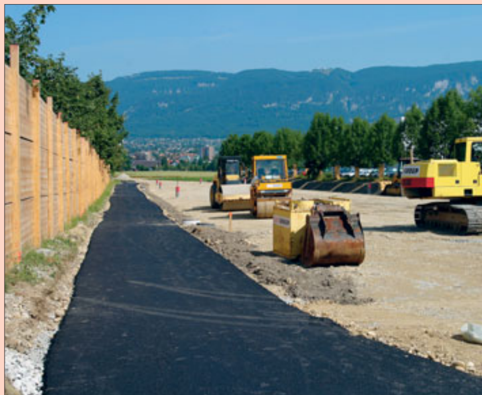
Baubeginn Dammschüttungsarbeiten; Baumschutzmassnahmen.
